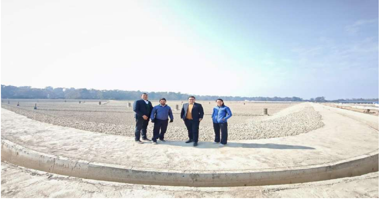
धनगढी उप-महानगरपालिकाको निर्माणाधिन Land fill Site पटेला
