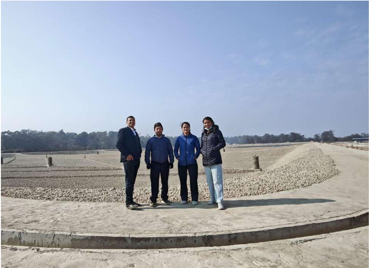
धनगढी उप-महानगरपालिकाको निर्माणाधिन Land fill Site पटेला
